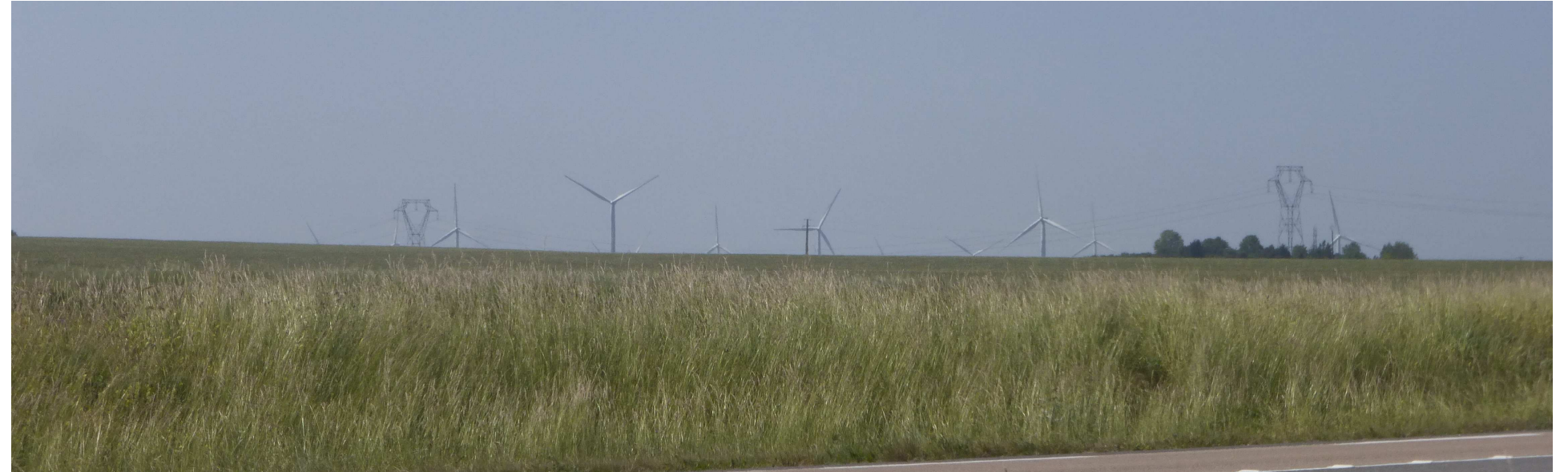
Le parc éolien de Fère-Champenoise, Euvy et Corroy, depuis la route nationale N4 (Photo 64)
