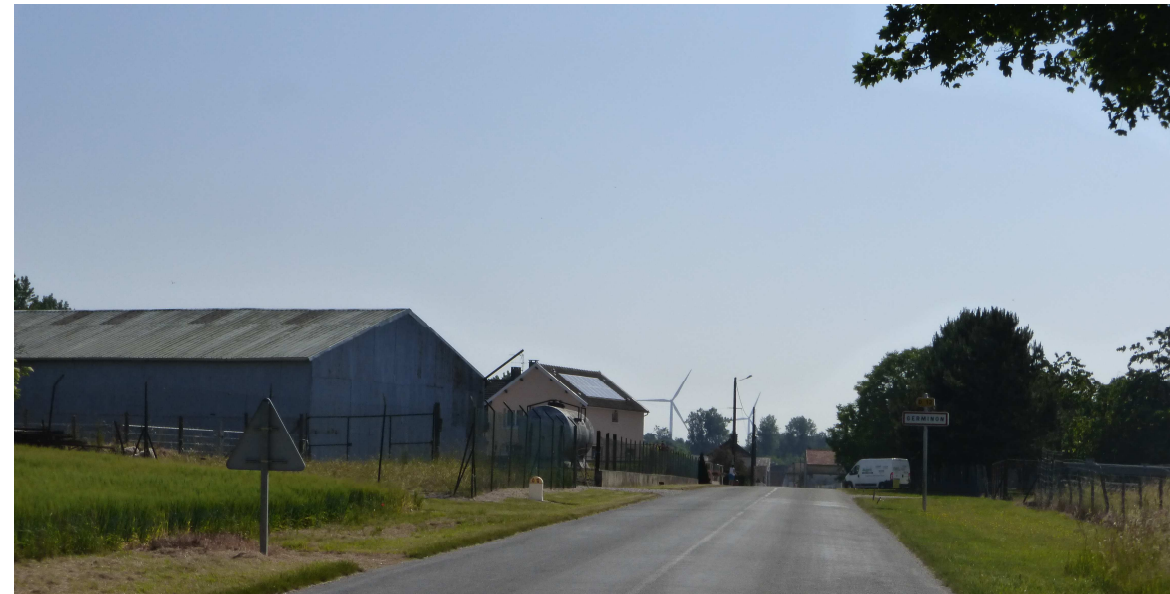
Rapport d'échelle entre les éoliennes et le village de Germinon (Photo 14)
